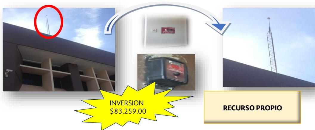
Así mismo, se realizó la instalación de un contador de descargas eléctricas dentro del área protegida, con el fin de verificar la efectividad de la antena pararrayos. De igual forma, para brindar una mayor protección al equipo de red contra descargas eléctricas se instaló un protector contra descargas eléctricas para UTP, mismo que se instaló en el rack del Site del Edificio B.
